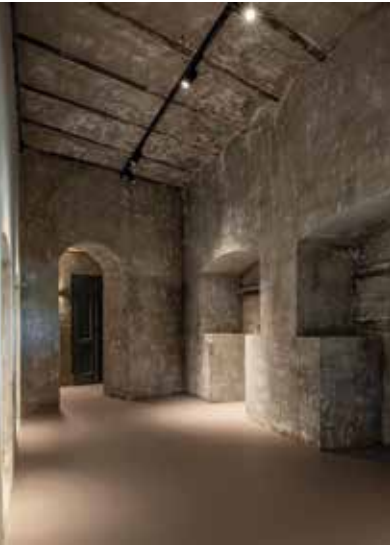
In questa pagina. A sinistra: la scala di collegamento con i corridoi sotterranei della postieria, scavati parzialmente per essere riutilizzati. Due foto al centro: la casamatta al piano terra. È stata completamente spogliata e sabbiata, per enfatizzare la tattilità e la qualità scultorea del cemento; il pavimento è ora dotato di riscaldamento, le postazioni dei cannoni di doppi vetri. A destra: il corridoio che collega tutte le stanze del piano terra, ora utilizzate come studi per creativi. Pagina a fronte, dall'alto: l'area che ospitava i cannoni, ora spazio per mostre; vista della postieria, luogo di collegamento tra l'edificio principale e la corte superiore
